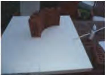
Nachdem das Fundament getrocknet ist mit YTONG Steinen ein U aufmauern. Die Vorderseite bleibt noch offen um dort später den unteren Bogen einzumauern. Zum verkleben habe ich hochflexiblen Fliesen Kleber für draussen verwendet.
