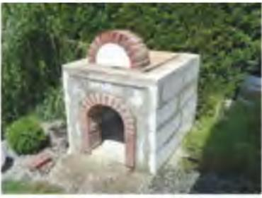
Wie beim unteren Rundbogen habe ich mir auch für den oberen Rundbogen 2ine Schablonen aus Dämmplatten gebaut und die Klinkersteine über beide Platten gelegt und vermortelt. Da auch der vordere Teil des späteren Brennraums durchaus warm wird habe ich dafür bereits feuerfesten Beton verwendet und ein Stahlgitter (Draht) oben mit eingearbeitet.
